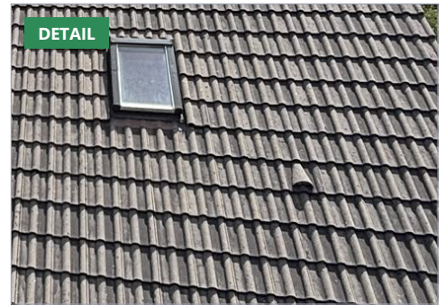
Derselbe Ausschnitt nach der Reinigung. Fugen frei, Oberfläche der Dachsteine unbeschädigt.
