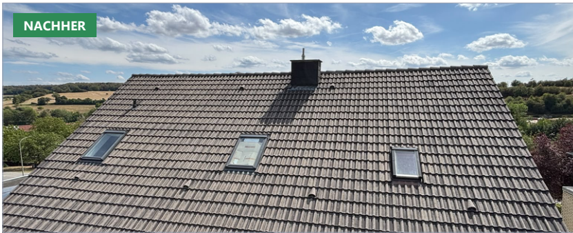
Gesamtansicht nach Reinigung und Versiegelung, aufgenommen vom selben Standpunkt wie das Vorher-Foto.
