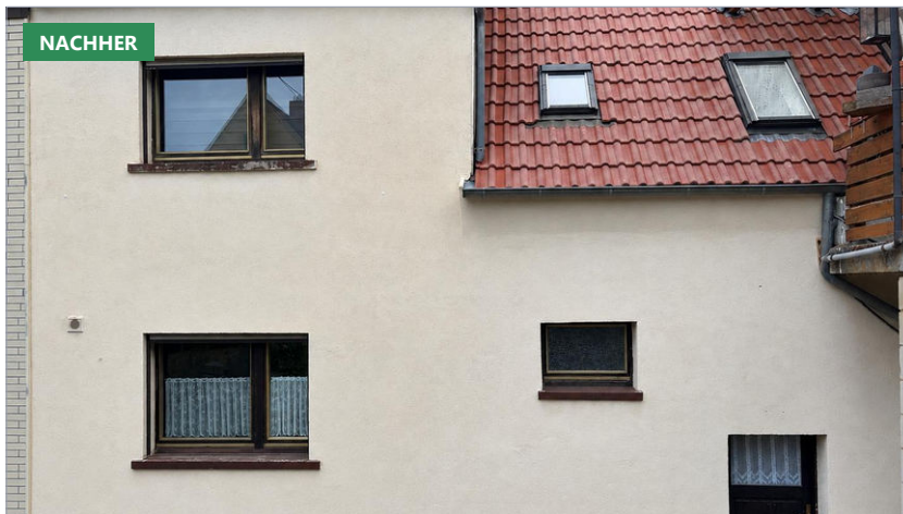
Gesamtansicht nach der Reinigung, vom selben Standpunkt wie das Vorher-Foto.
